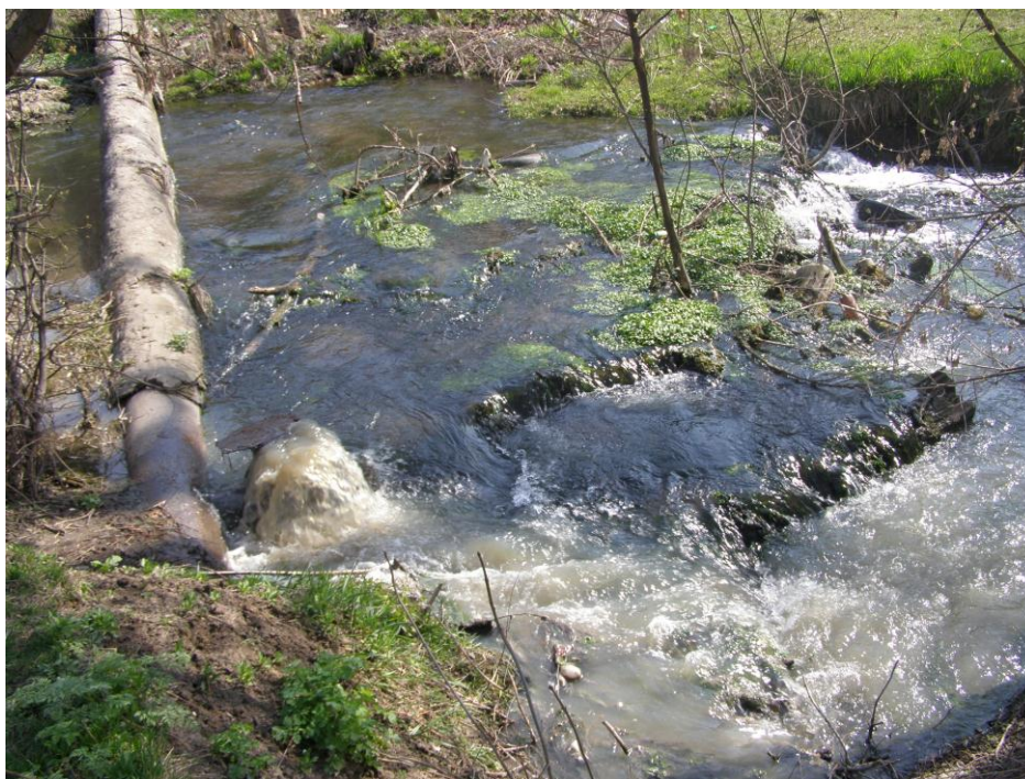
Фото 11. Порыв канализационного коллектора Перевальск-Алчевск
